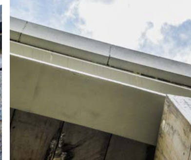
5. Lateral del viaducte ja reparat i protegit amb pintures impermeabilitzants.
