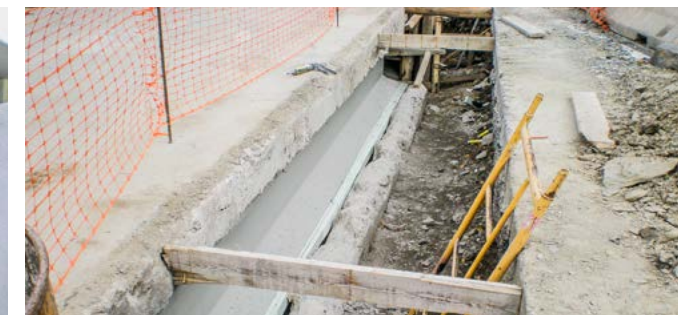
3. Zona adjacent al mur interior i que s'ha enderrocat per reparar la biga més propera. Una vegada reparades les bigues s'ha restituit el mur.
