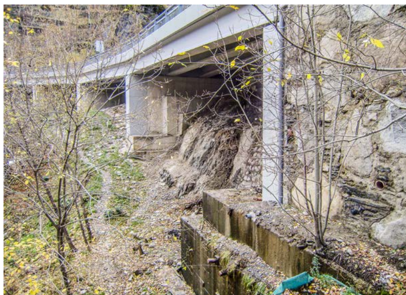
>>> Viaducte amb la rehabilitació efectuada
