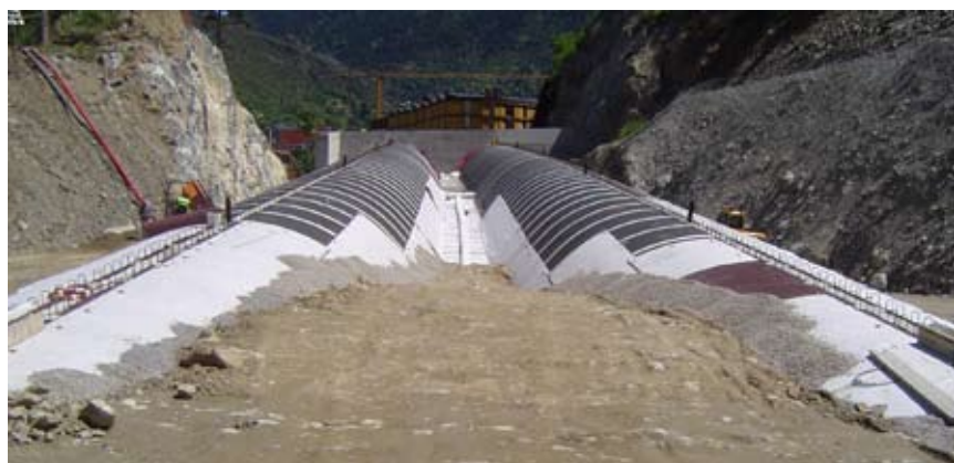
S'han col·locat un total 138 peces que van ser transportades d'una en una fins a l'obra. Estat de l'obra el 19-07-2011.
