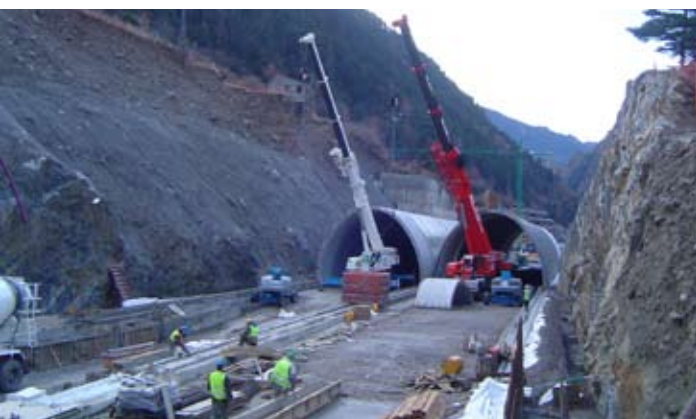
Les dovelles que conformen els falsos túnels han estat fabricades per Adhorna, a la població de Calaf (Barcelona). Estat de l'obra el 9-12-2010.
